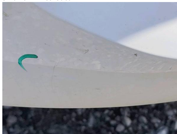
Slika R01-1: Poškodba
