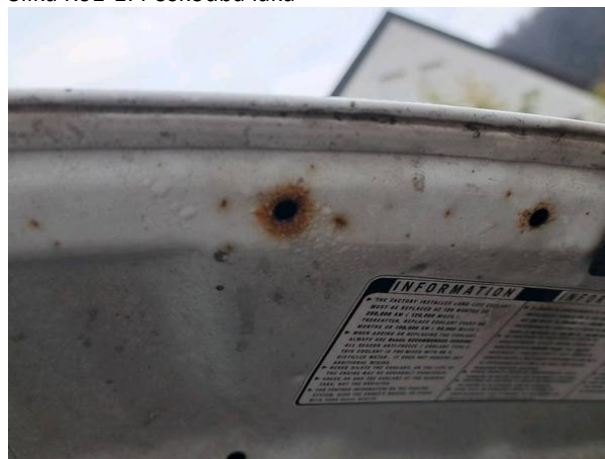
Slika R01-1: Poškodba laka
