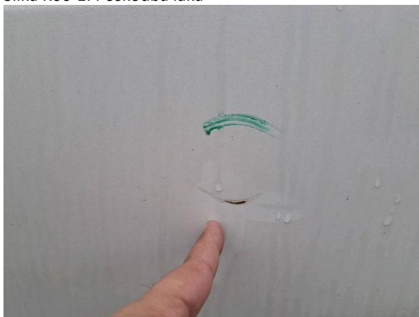
Slika R06-1: Poškodba laka
