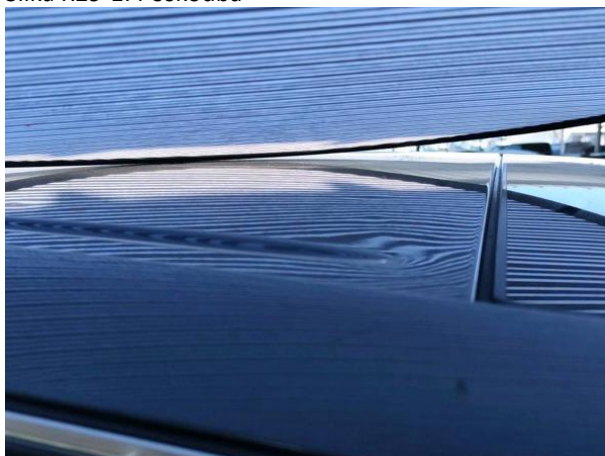
Slika R29-1: Poškodba
