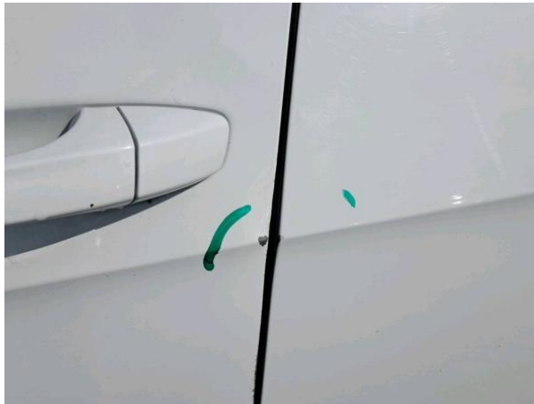
Slika R08-1: Poškodba laka
