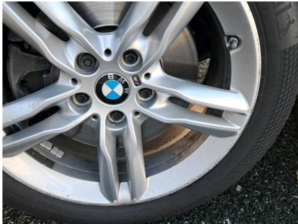
Slika R03-1: Poškodba laka
